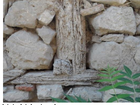
Resim 6, 7. Ahşap dikme ve kiriş birleşim detayı 5292 ada 1 parsel / 5382 ada 2 parsel [7]
