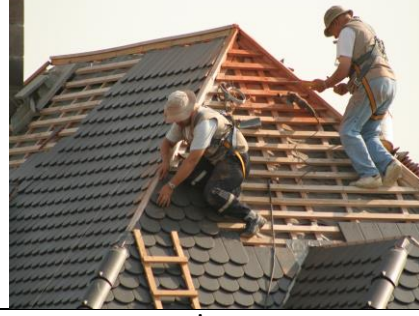
Fotoğraf 9. Çatı İşlerinde KKD Kullanımı [26]
