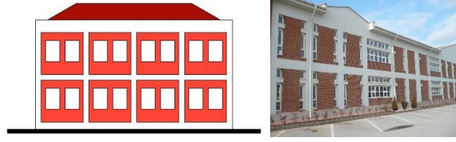
Şekil 5. Cephe kaplama tuğlasının uygulandığı bina yüzeyinde strüktürel (kolon-kiriş) etki-1
