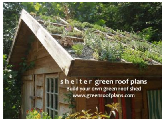
Şekil-6: Kırma çatıda ekstansif bitkilendirme
