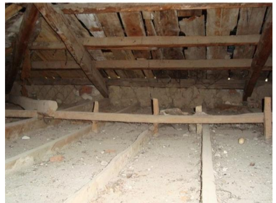
Resim 16. Aynı yapının üzeri toprak ile örtülmüş çatı döşemesi
