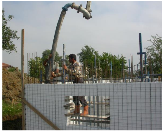
Şekil 2. Duvar panellerinin yerleştirilmesi [5] Şekil 3. Duvarların betonlanması [5]
