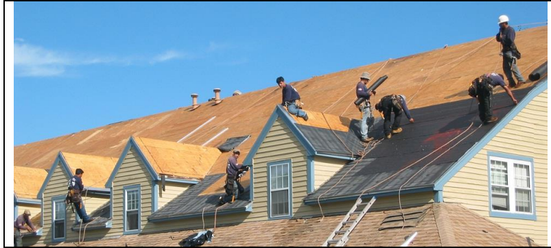
Fotoğraf 12. Çatı İşlerinde KKD Kullanımı [29]
