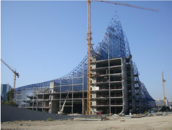
Resim 7. Paraboloidin yapım aşaması [7]
