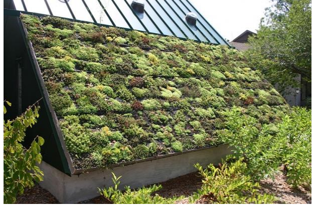
Şekil-9: Sedum sp. kırma çatıda uygulaması (Ancaya Green Roof Garden Shed, 2014)
