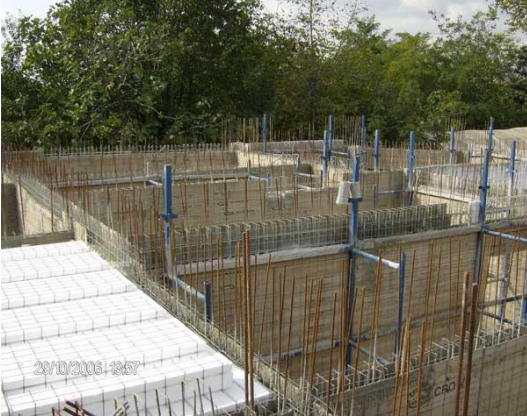
Şekil 5 Döşeme panellerinin hazırlanması [5]
