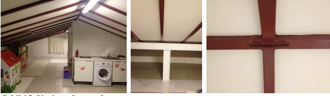
Şekil 15. Yeni çatı bütünsel görünüş
