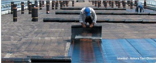
Şekil-3: Yalıtım membranı rulolarının yerleştirilmesi (8).
