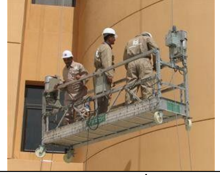
Fotoğraf 3. Cephe İşlerinde Hareketli İskele [20]
