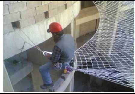
Fotoğraf 5. Cephe İşlerinde KKD Kullanımı [22]
