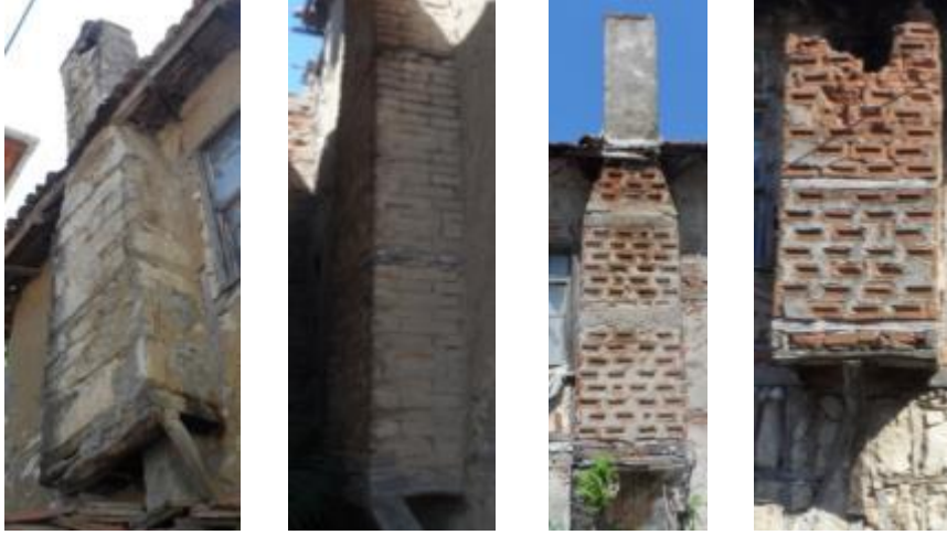
Resim 11-14. Taş ve Tuğla Baca Detayları.
