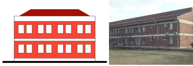
Şekil 6. Cephe kaplama tuğlasının uygulandığı bina yüzeyinde strüktürel (kiriş) etki-2
