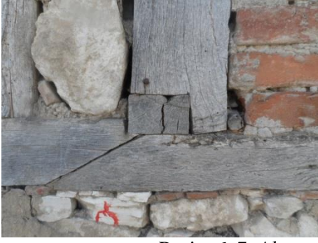
Resim 6, 7. Ahşap dikme ve kiriş birleşim detayı 5292 ada 1 parsel / 5382 ada 2 parsel [7]
