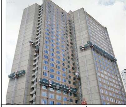
Fotoğraf 1. Cephe İşlerinde Hareketli İskele [18]
