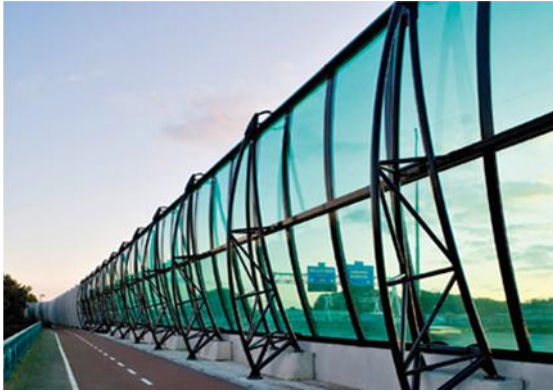
Şekil 4. Polikarbonat Ses Bariyerleri [10]
