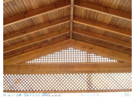
Şekil 9. Ahşap taşıyıcı sistemli beşik çatı.
