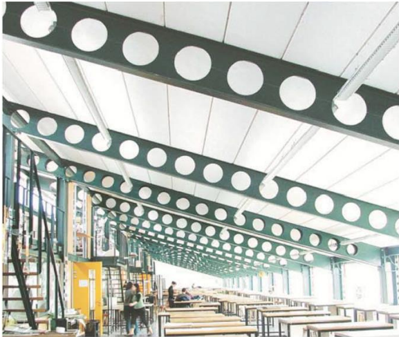
Resim 6: Gazbeton Donatılı Çatı Paneli Örnek Uygulama
