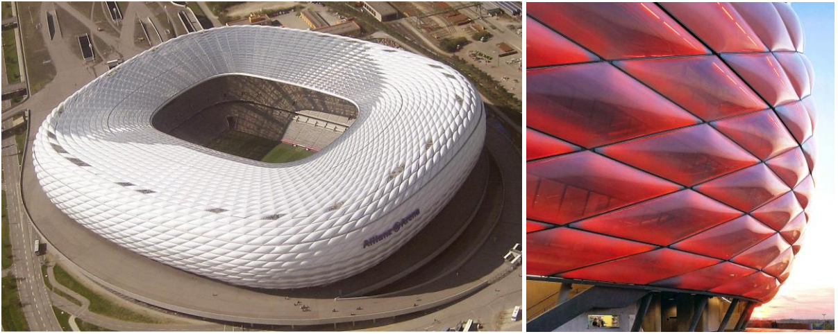
(a) (b) Şekil 1: Allianz-Arena. (a) Kuşbakışı görünüm ( http://commons.wikimedia.org ) (b) Kırmızı aydınlatılmış ETFE cephe ( http://buildingskins.wordpress.com )
