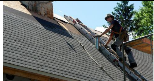
Fotoğraf 7. Çatı İşlerinde KKD Kullanımı [24]
