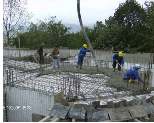
Şekil 6. Döşemenin betonlanması [5]
