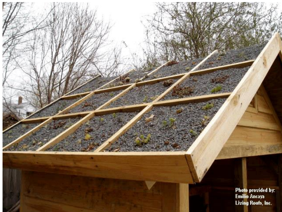
Şekil-5: Kırma çatıda çapraz tahtaların yerleşimi bitkilendirme
