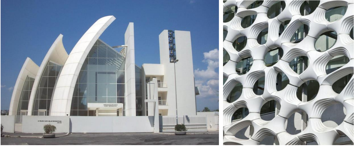
(a) (b) Şekil 8: (a) Jübile Kilisesi / Fotokatalitik çimentolu prekast beton KT/HT cephe [9] (b) Manuel Gea Gonzalez Hastanesi / Fotokatalitik beton KT/HT çift cephe [13]
