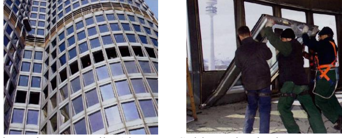
Şekil 2.3 BMW Merkez Binası, Münih, Almanya. Solda cephenin dıştan görünüşü, sağda izolasyonlu ek kabuğun iç mekandan cepheye montajı [7].
