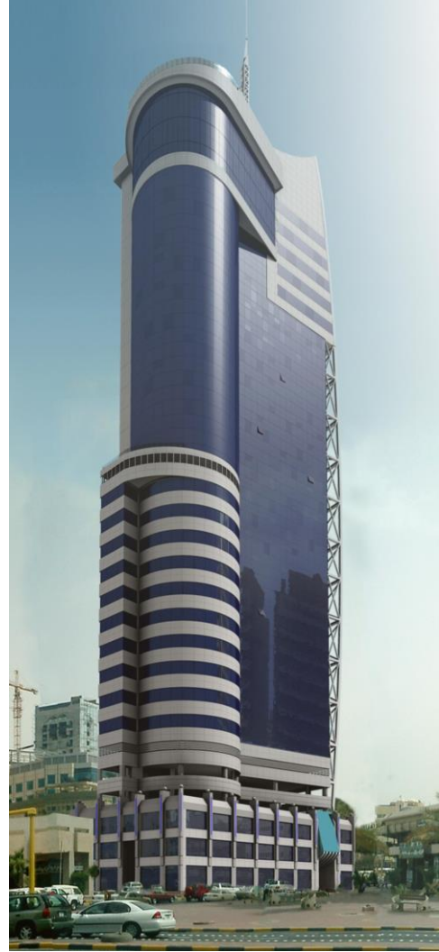
Şekil 10: Al Jawhara Tower / Pasif KT Cam Giydirme Cephe [16]
