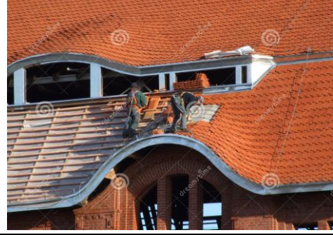
Fotoğraf 11. Çatı İşlerinde KKD Kullanımı [28]
