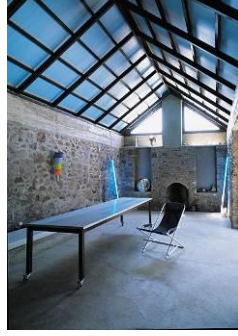
Şekil 8. Çelik taşıyıcı sistemli beşik çatı.
