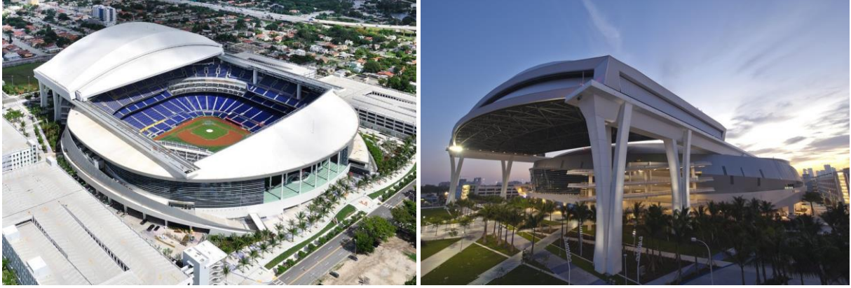
(a) (b) Şekil 6: Marlins Park Beysbol Stadyumu ( http://www.rancomfl.com ) (a) Kuşbakışı görünüm (b) Hareketli çatının taşıyıcı ayakları.
