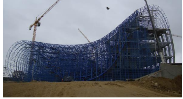
Resim 6. Hiperbolik parabolün yapım aşaması [7]
