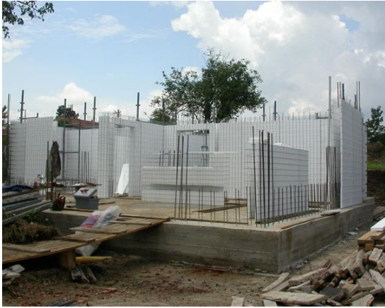
Şekil 2. Duvar panellerinin yerleştirilmesi [5] Şekil 3. Duvarların betonlanması [5]
