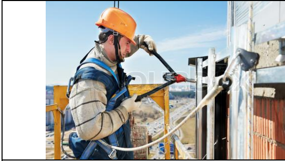
Fotoğraf 4. Cephe İşlerinde KKD Kullanımı [21]
