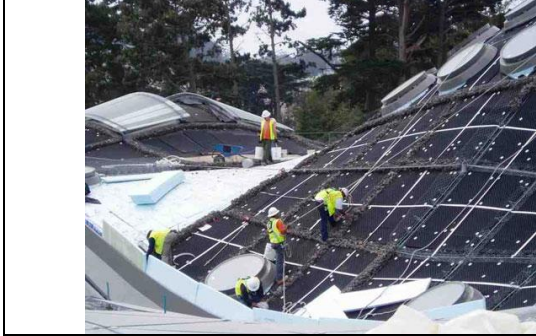
Fotoğraf 10. Çatı İşlerinde KKD Kullanımı [27]
