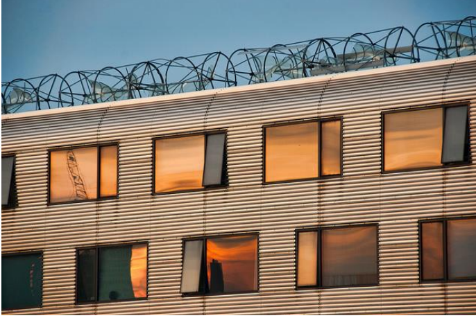
Şekil 6. Metal panel kaplama cepheden görünüm [8]
