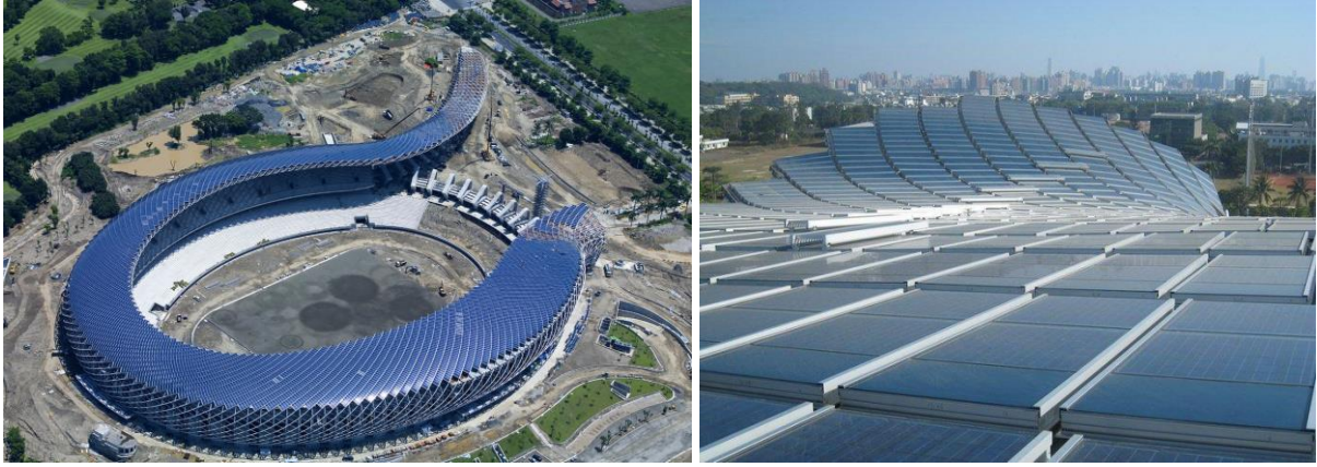
Şekil 4: Kaohsiung Dragon Stadyumu [8] (a) Kuşbakışı görünüm (b) Çatıya konmuş BEFV modüller.
