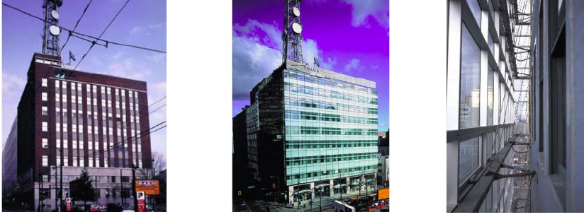
Şekil 2.2 William Farrell Telus Binası, Vancouver, Kanada. Solda binanın yenilemeden önceki görünüşü, ortada yenilemeden sonraki görünüşü, sağda mevcut ve yeni kabuk arasındaki boşluktan görünüş [6][10].
