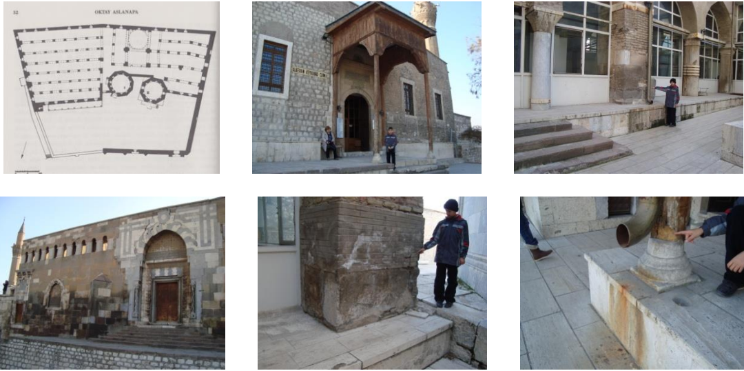
Şekil 1. Konya Alaeddin Camii (Çizim, O., Aslanapa) [6] cephelerde su-nem sorunlarının olduğu görülmüştür.
