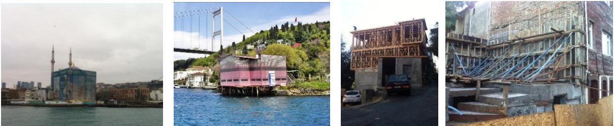
Şekil 1. Ortaköy Camisi Restorasyon Şantiyesi.
