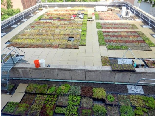
Şekil-8: Sedum sp. düz çatıda uygulaması (Ancaya Green Roof Garden Shed, 2014)
