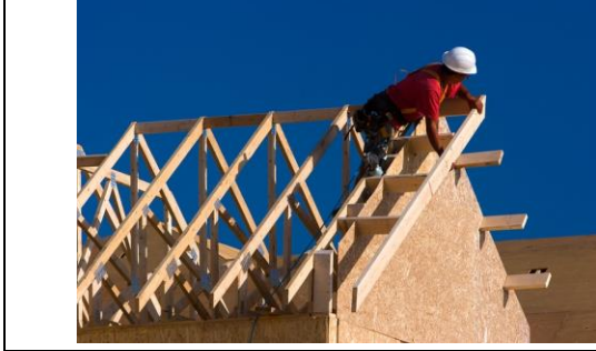
Fotoğraf 8. Çatı İşlerinde KKD Kullanımı [25]
