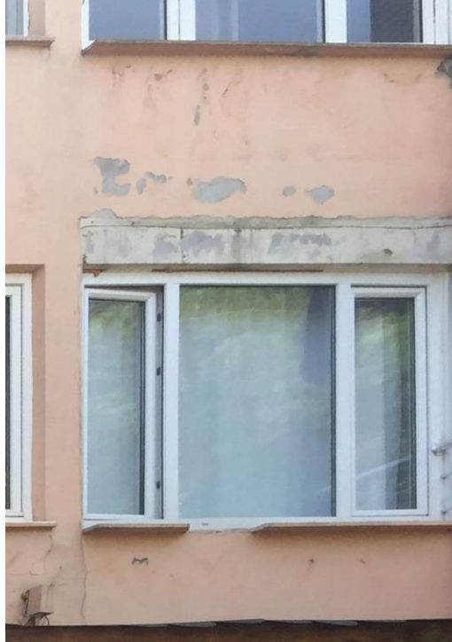
Şekil 3.11 Kırılmış denizlik [2].
