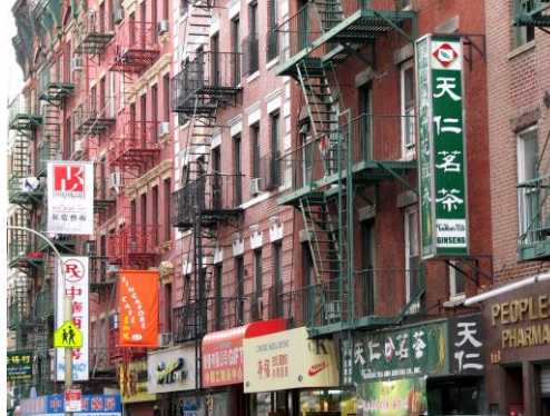
Resim 11. Yangın Merdiveninde alınan önlem [URL.11]
