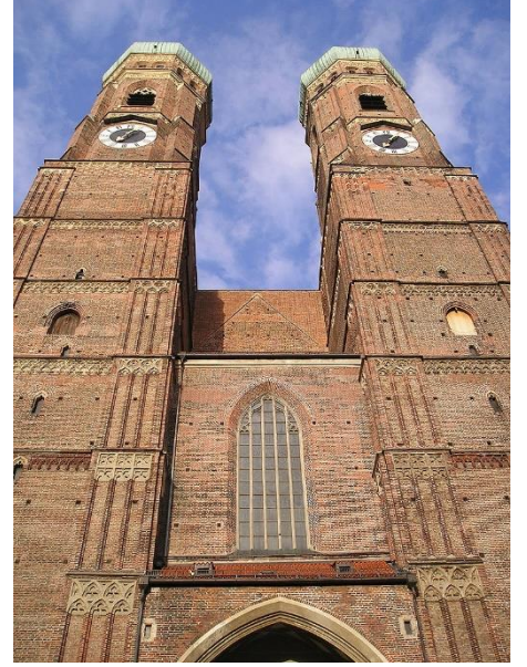
Foto.4. Kathedral Binası, Almanya 15 yy. [12]
