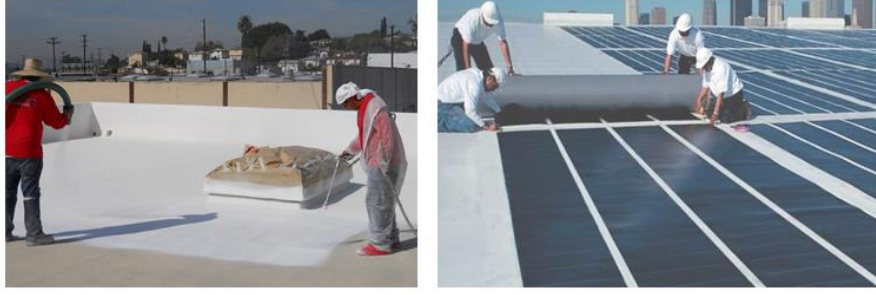
Şekil 4.2. Düşük Eğimli Çatıya Sıva Püskürtülmesi, Serin Çatı Üzerinde Fotovoltaik Güneş Panelleri Montajı.
