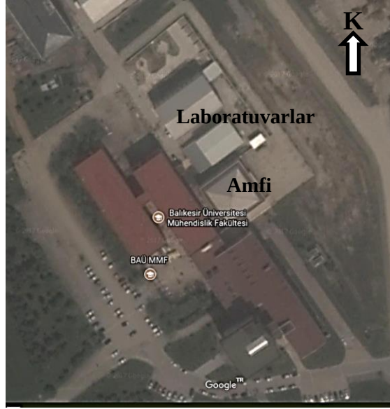
Resim 2. Mühendislik ve Mimarlık Fakültesi Google Earth
