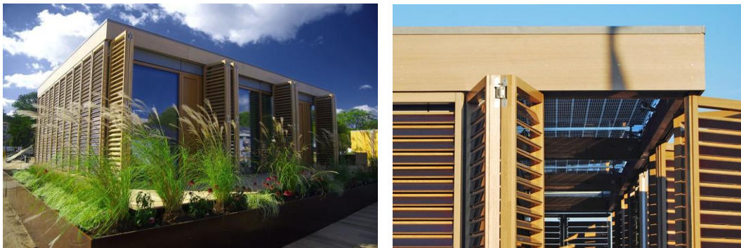
Fotoğraf 4. Cephe panjur sisteminin fotovoltaiik panellerle desteklenmesi [10]
