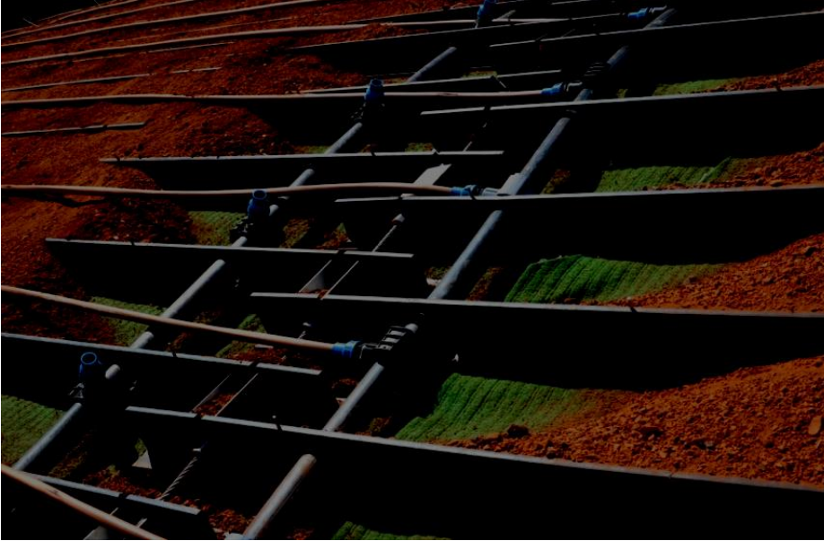
Resim-8 Su Tesisatı
