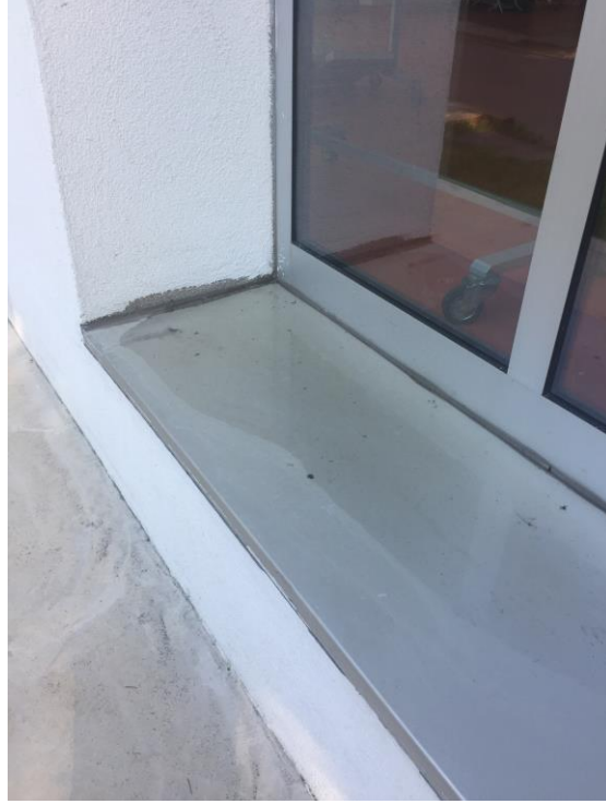
Şekil 3.4 Denizlikte yağmur suyu birikimi [2].
